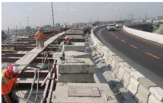
Travaux de l'autoroute 409
