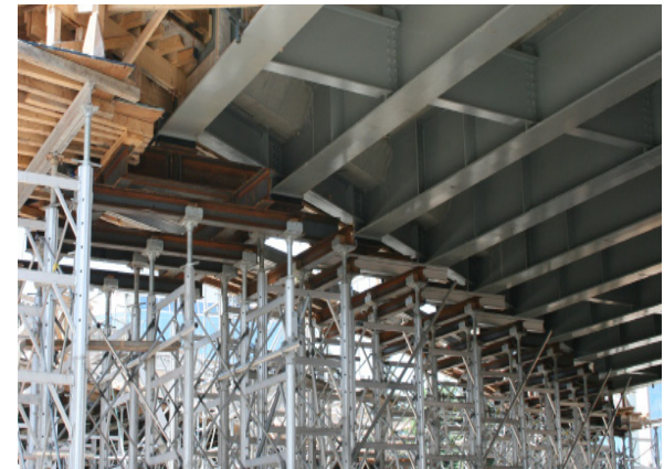
Préparation des travaux du pont de l'avenue Carling
