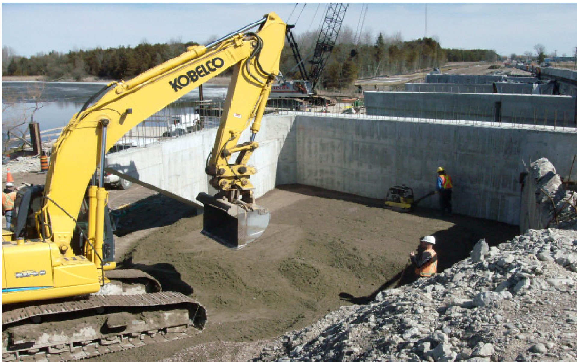
Route 7, fondations achevées du pont de la rivière Scugog
