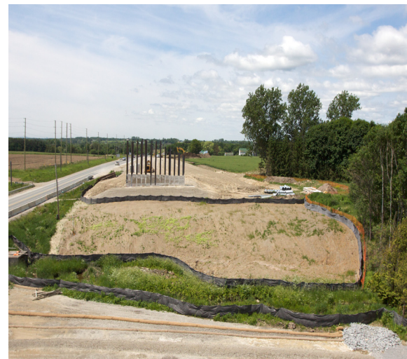
Travaux en cours du prolongement de l'autoroute 407
