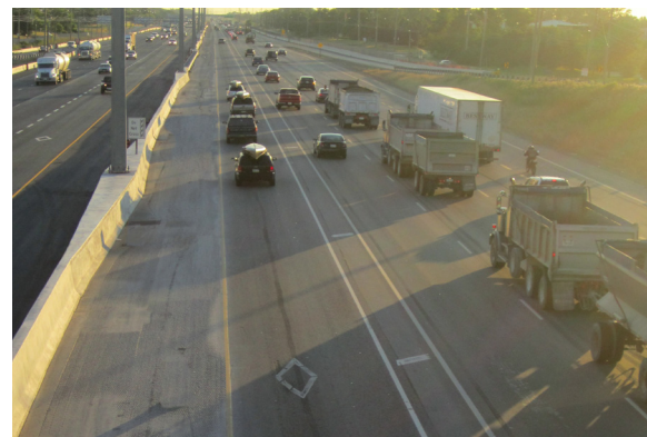
Voies réservées aux VMO sur l'autoroute QEW, après les travaux
