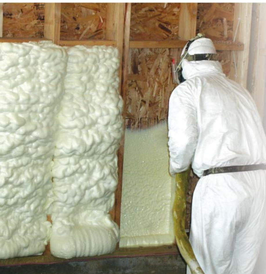
Pose de l'isolant en mousse écologique et éconergétique d'Icynene.
