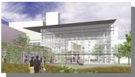
Centre de santé Trillium Campus de Toronto Ouest
