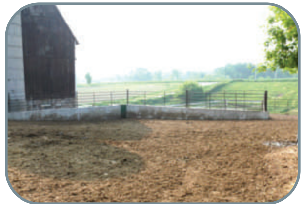
Figure 1 : Enclos muni d'une cloison de retenue servant de stockage temporaire pour l'écoulement
