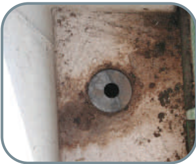
Figure 3 : Une plaque à orifice d'un diamètre approprié est placée derrière la grille afin de contrôler le flux
