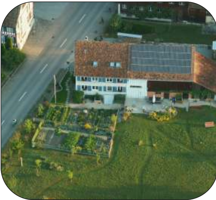
Figure 1. Installation solaire photovoltaïque sur une résidence d'Hohentannen.
