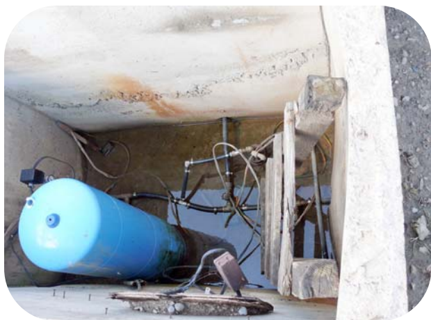
Photo 2. Vue intérieure d'une fosse de visite
