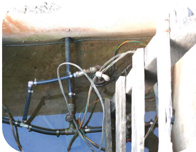
Photo 3. Tête de puits dans une fosse de visite
