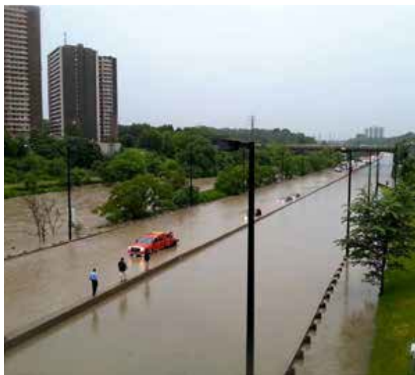
Crédit photo : Toronto Hydro
