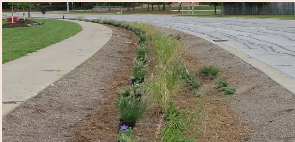
Les écobaiSSIères absorbent et nettoient les eaux pluviales avant qu'elles se jettent dans le ruisseau de Brampton, en Ontario. Crédit photo : Reproduite avec l'autorisation de l'office de protection de la nature de Toronto et des environs.
