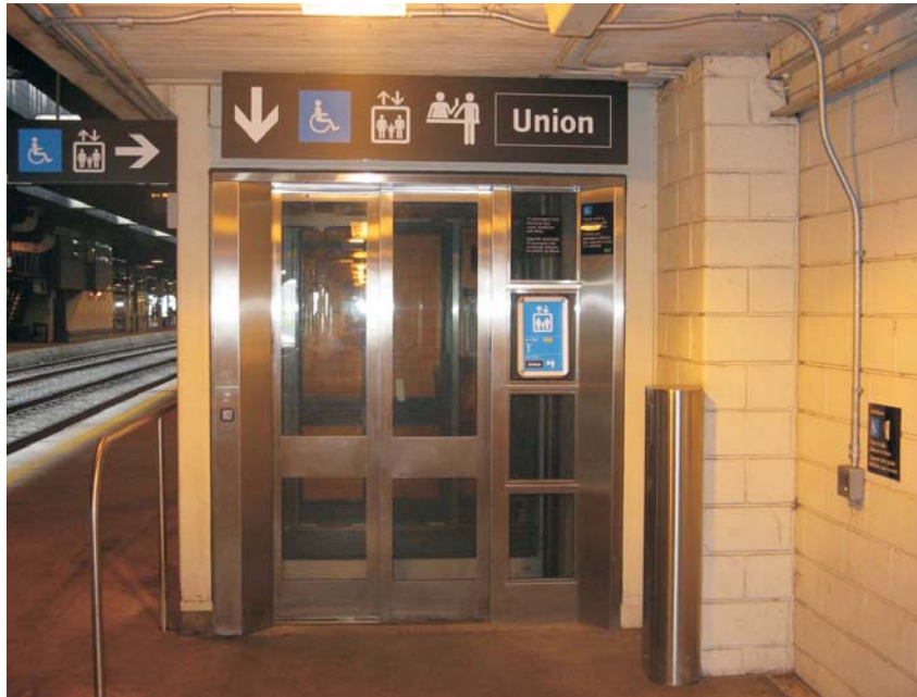
Panneaux d'ascenseur au Quai 1 au niveau de la voie ferrée de la gare Union
