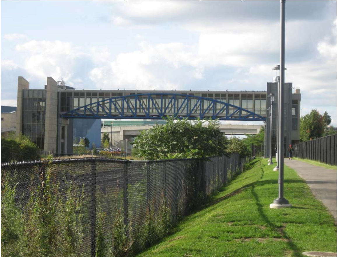
Passerelle piétonnière à la gare Langstaff
