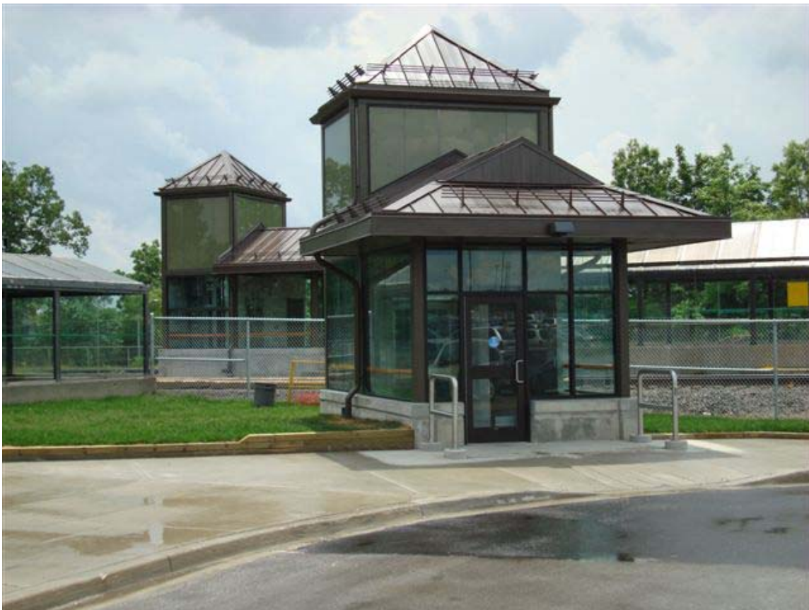
Ascenseur du tunnel d'entrée de la gare Erindale
