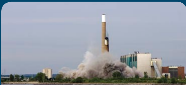
Ci-haut : la centrale au charbon Lakeview de Mississauga lors de sa démolition en juin 2006. D'ici la fin de 2014, l'Ontario cessera de brûler du charbon dans les quatre dernières centrales au charbon de la province.
