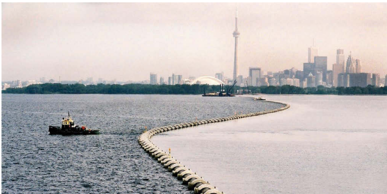
Photo : Enwave Energy Corporation, installation du système de refroidissement par eaux lacustres profondes d'Enwave.
