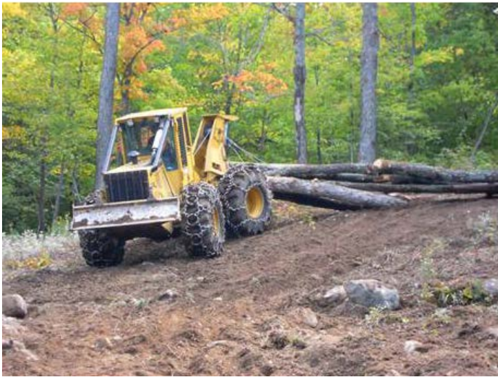
Abattage d'arbres à l'extrémité d'un boisé.
