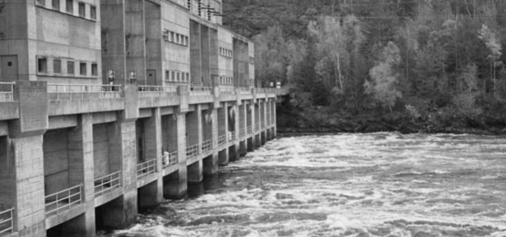
Centrale hydroélectrique sur la rivière Ottawa. Gracieuseté d'Ontario Power Generation.
