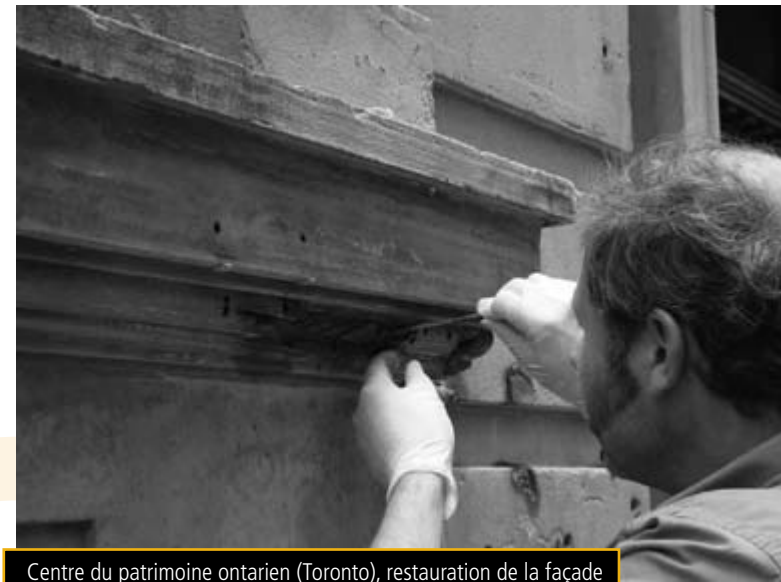
Centre du patrimoine ontarien (Toronto), restauration de la façade
