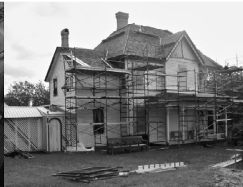
Travaux de restauration à la maison Mather-Walls, Kenora
