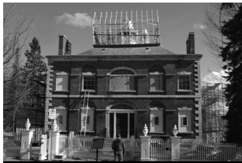
Travaux de restauration à la maison McMartin, Perth
