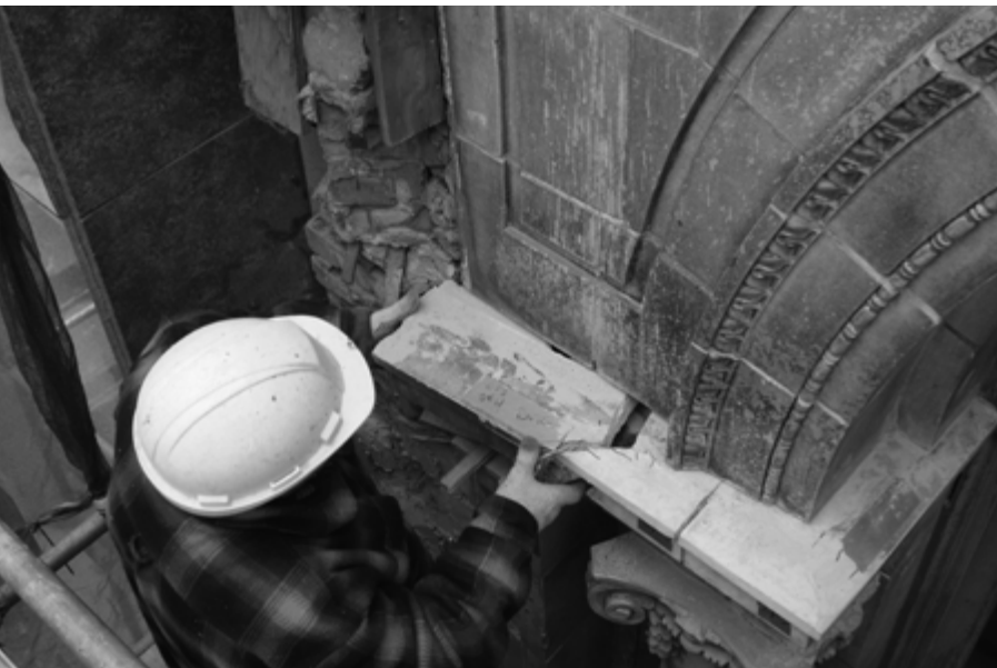
▲ Retrait d'un élément en terre-cuite en vue de sa reproduction, Centre des salles de théâtre Elgin et Winter Garden, Toronto
