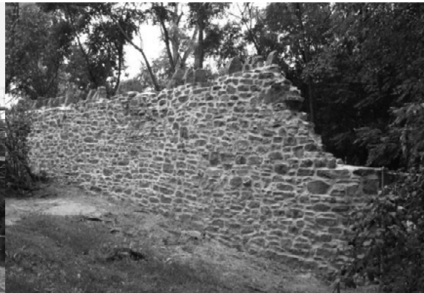
Mur de clôture en pierre à Inge-Va, Perth
