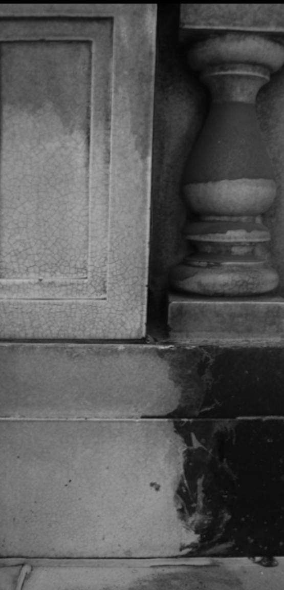
▼ Test de nettoyage de terre-cuite montrant le faïençage superficiel, Centre des salles de théâtre Elgin et Winter Garden
