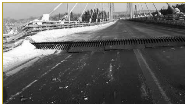
Figure 10 : Pont de la rivière Nipigon après la rupture de l'un de ses joints
