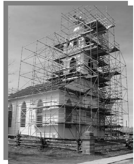
Réparations en cours à l'église du Christ (Upper Canada Village).
